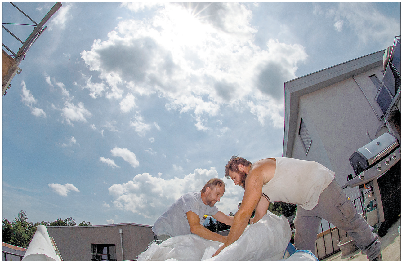
Ivo Stalder (links) und Vincenc Prenaj auf einer Baustelle in Hellbühl.
